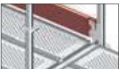
Montage des Holzbordbretts
